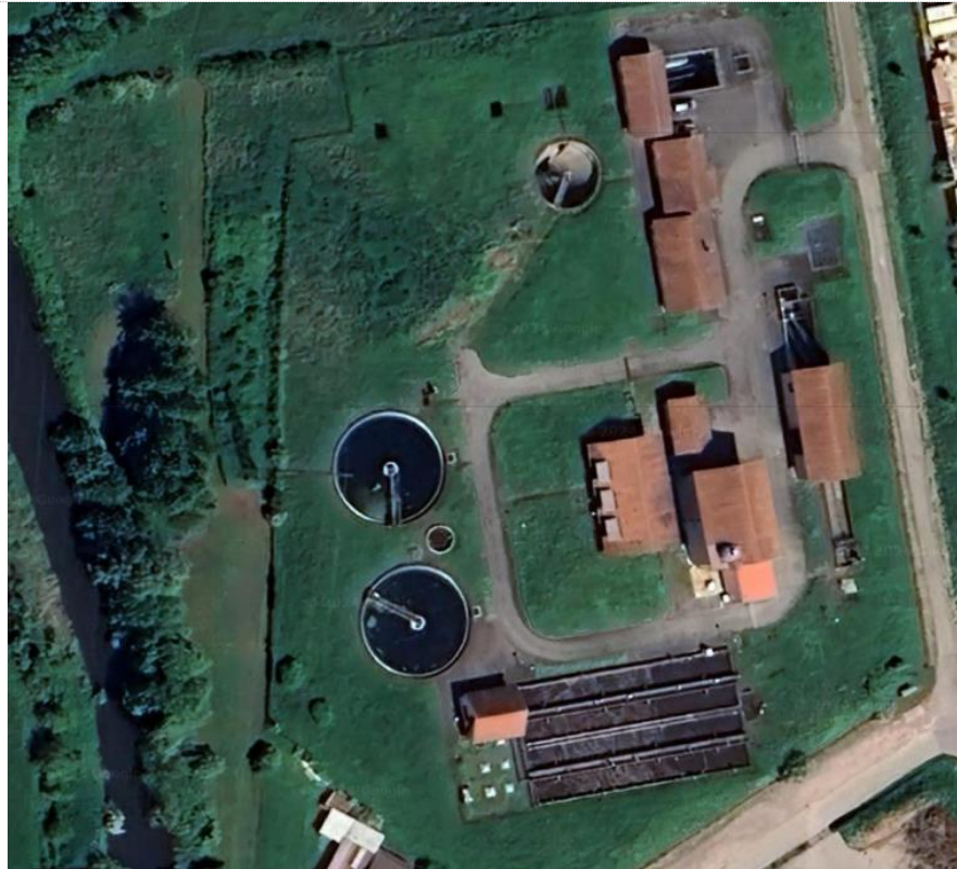
Abbildung 80: Luftbild Kläranlage Kenzingen (Quelle: Google Maps)
