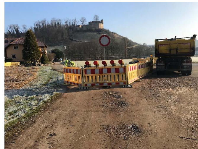
Straßensanierung Großmatt in Hecklingen
