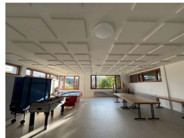
Akustikpaneelen Decke in der Schulbuckhalle
